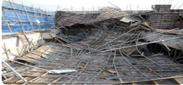
2018. 10. 22.(월) 공장 신축공사 현장에서 옥탑층 바닥 콘크리트 타설작업 중 붕괴[부상6]
