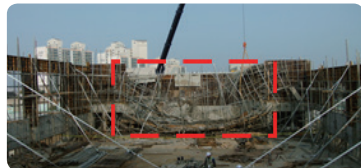
2010. 10. 21.(목) 학교 급식실 및 다목적 강당 신축공사 현장에서 무대실 슬래브 타설 작업 중 붕괴[사망1, 부상2]
