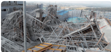
2010. 10. 9.(토) 공장증축공사 현장에서 옥탑층 바닥 콘크리트 타설작업 중 붕괴[부상10]
