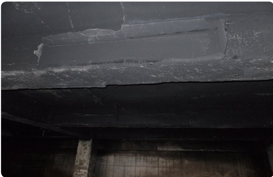
[사진2] 지하1층(화재발생장소) 천장 단열재 연소 상태
