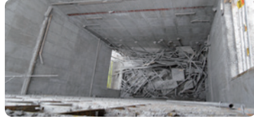
2010. 4. 10.(토) 공장 증축공사 현장에서 화물용 E/V 기계실 슬래브 콘크리트 타설 후 마무리 작업 중 동바리가 붕괴[사망1, 부상1]
