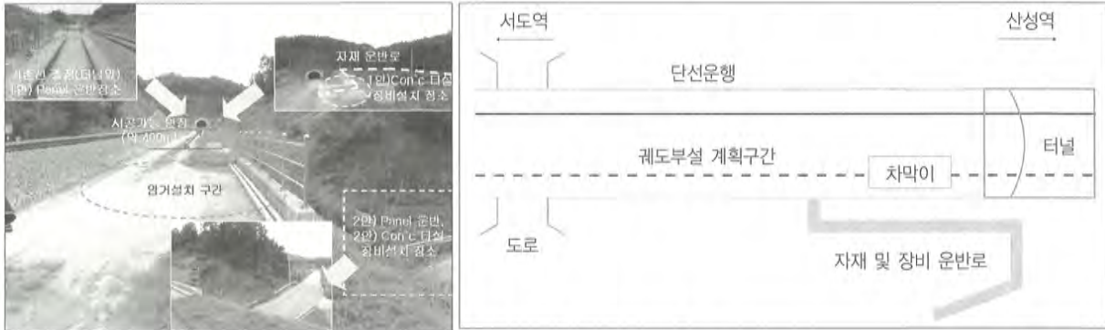
<그림 1> 현장부설 장소로 선정된 서도~산성 구간
