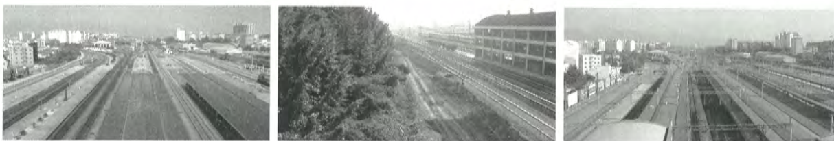
1, 2. 대구선 이설 작업 전의 동대구역 전경
